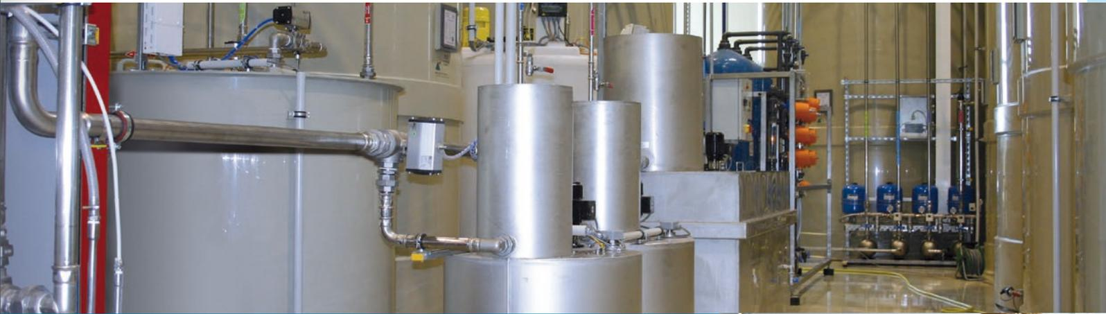
Unsere hochentwickelten und im Einsatz erprobten Vakuum-Verdampfer der Serien PROWADEST®, DESTIMAT® und ECO setzen Maßstäbe in der Wasseraufbereitung. Sie bieten unseren Kunden in Kompaktform eine sparsame Alternative zur Behandlung industrieller Abwässer. Und das mit Durchlaufleistungen von 25 bis zu 5.000 l/h.
